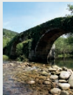
4 Ponte Românica sobre o rio Póio
